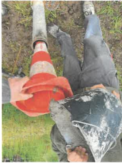
Cimentation du dernier mètre jusqu'au sol
