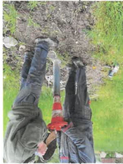
Comblement avec des graviers propres jusqu'à -1m du sol
